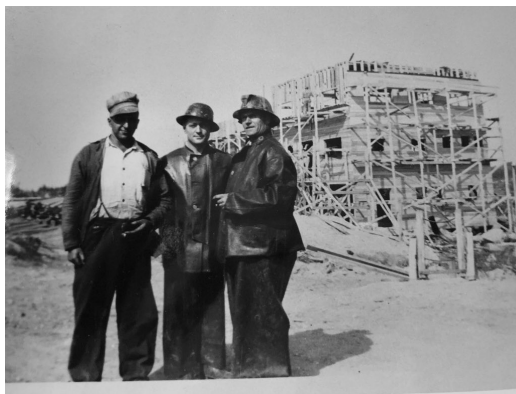
Eugène Gilbert à g. surveille la construction de la Salle paroissiale
